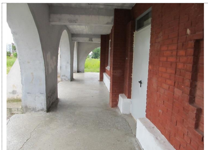
Фото №3 – Входная площадка главного входа
